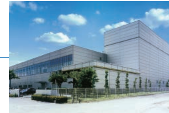
入間工場(狭山台)(埼玉県入間市)
