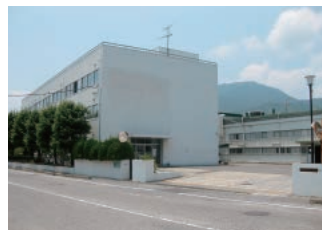
広島工場(広島県廿日市市)
